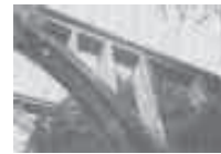
只見線大谷川橋梁（1939年）
