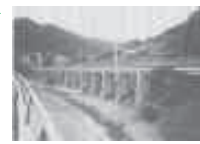
内房線山生橋梁（1924年）
