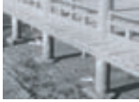
厳島神社の床下柱の根継ぎ
