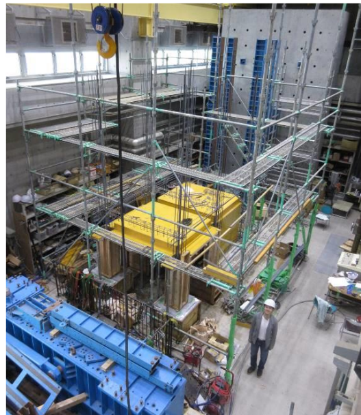
製作の様子（2019/10/9 現在，2 階床レベルの配筋中）
